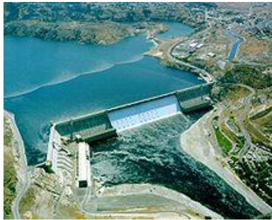
Fig 1.1 Grand Coulee Dam : (Source-Google images)
